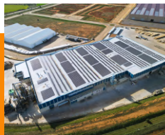
INDUSTRIAL ROOFTOP LOSÁN
