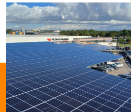
CARPORT SOLAR YAZAKI
