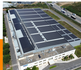
COBERTURA INDUSTRIAL TESCO
