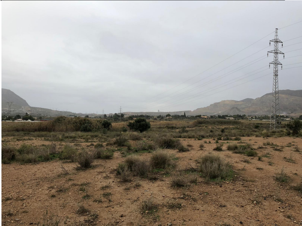
Imagen 12: Redes y tendidos eléctricos existentes en la zona.
